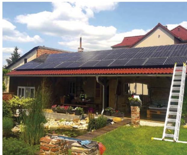
Reference ELKOV energy: Kompletní dodávka komponentů pro FVE ve Strakonících
