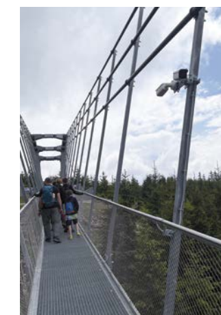
Další kamery značky Hikvision umístěné na Sky Bridge 721
